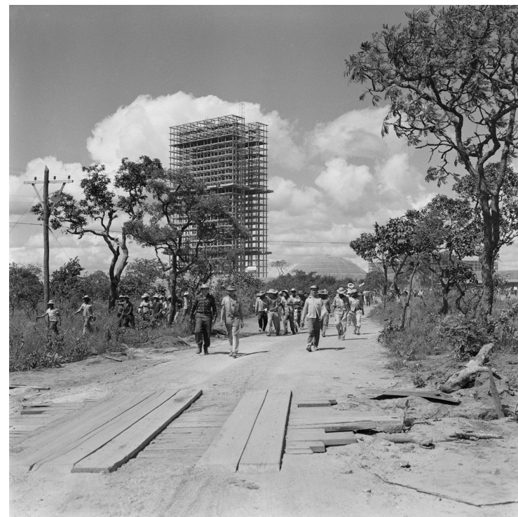
Congresso Nacional em construção, 1959
