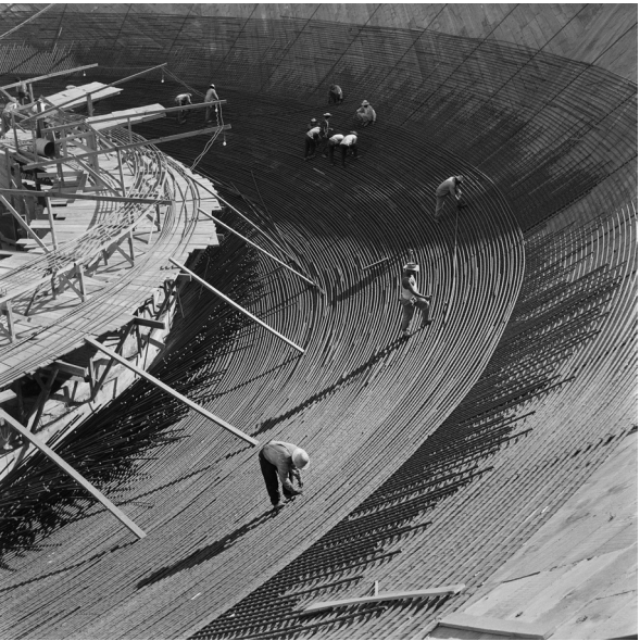
Congresso Nacional em construção, 1959
