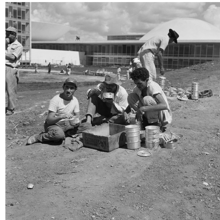
Congresso Nacional em construção, 1959
