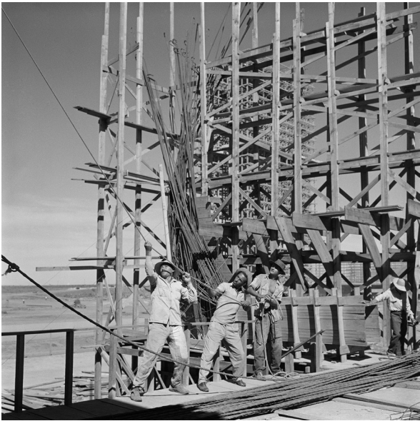
Congresso Nacional em construção, 1959
