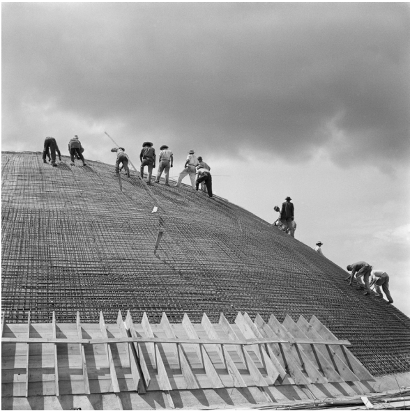
Congresso Nacional em construção, 1959
