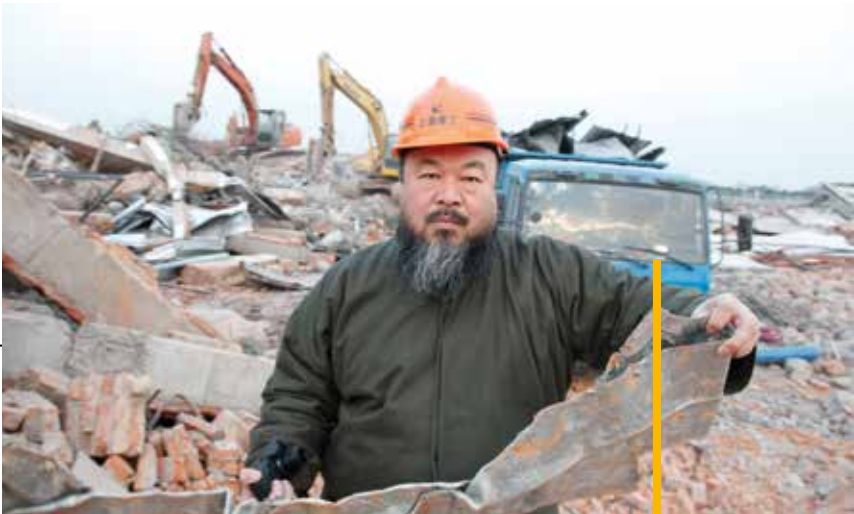
Demolición del estudio de Shanghai, Shanghai studio demolished, 2011.
